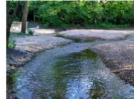
1 | kamenný zához překrytý drobnými oblázky
