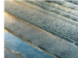
4 | vodní trasa - betonové strukturované koryto
